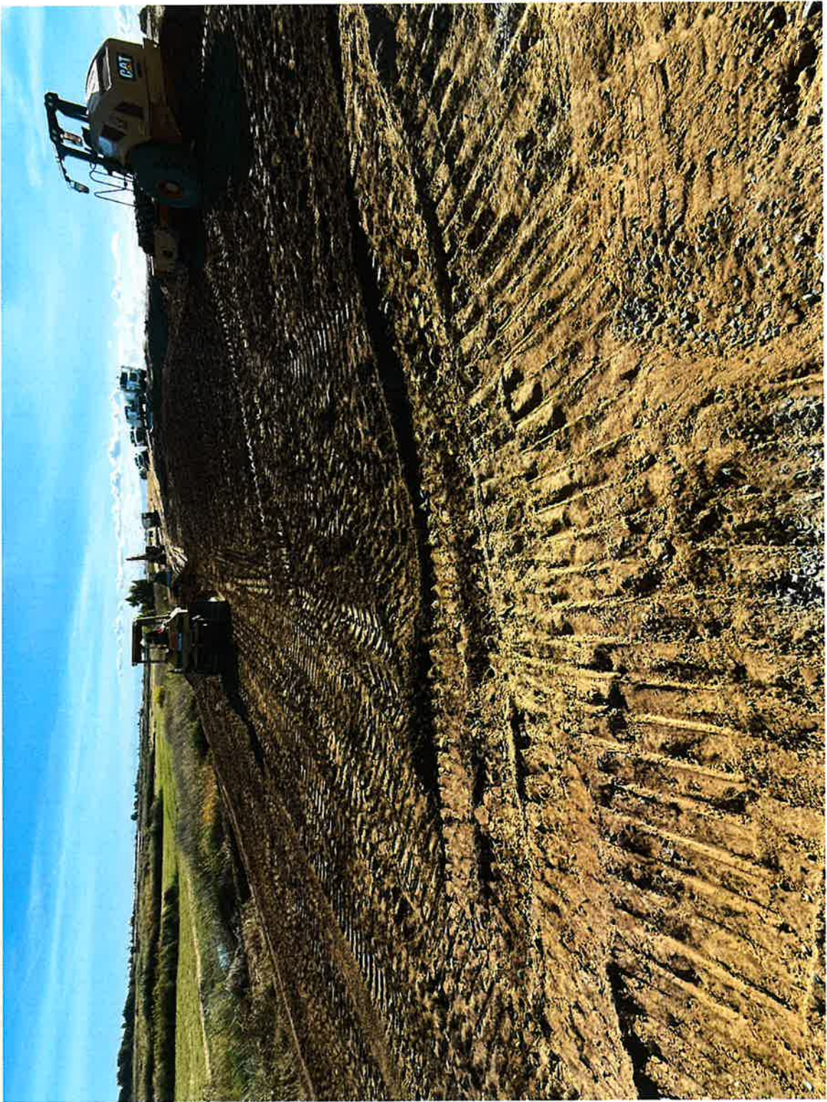
Placing fill material.
